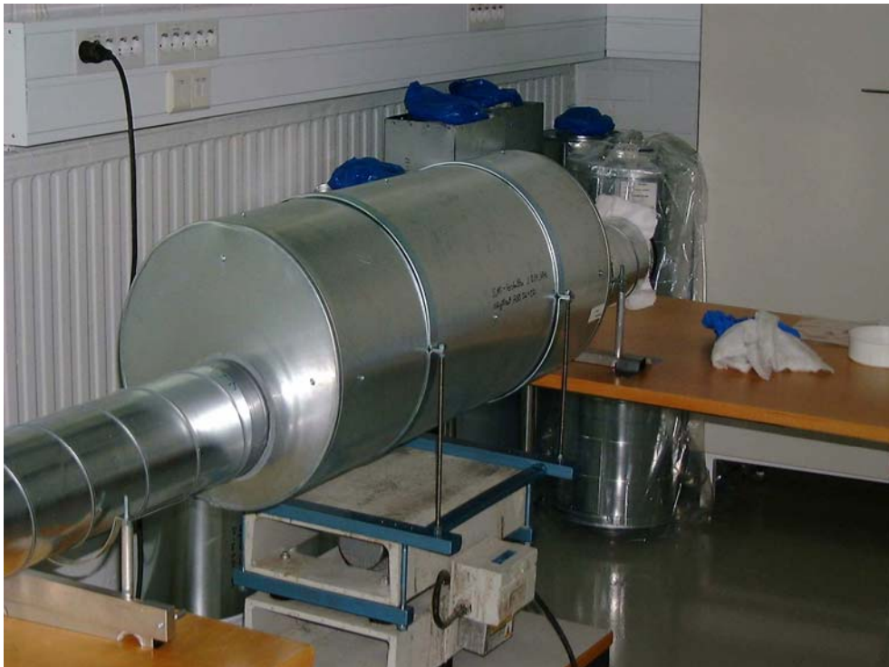
Kuva 2. Testattava tuote tärinäalustalla pantakiinnityksellä.
